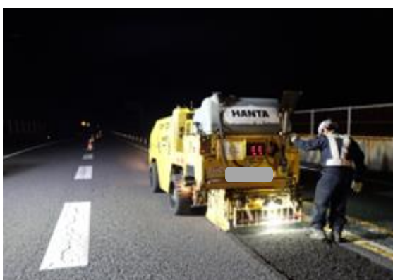
<舗装補修工事>
