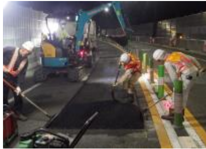
《舗装補修工事イメージ》
