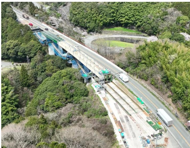
〈上部工工事現場〉
