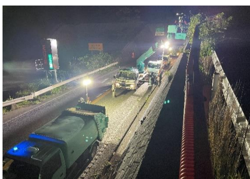
〈樹木伐採作業〉
