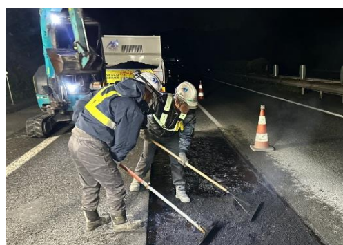
〈路面補修工事〉
