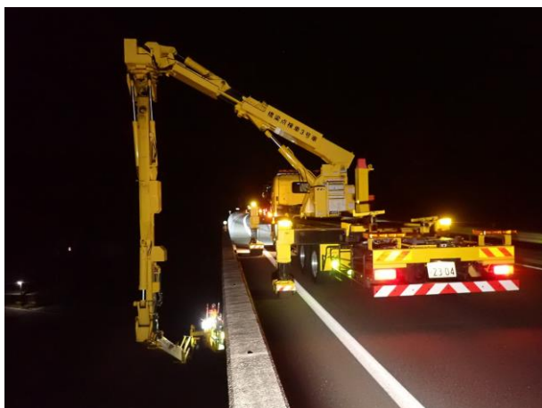
<構造物点検(橋梁)>
