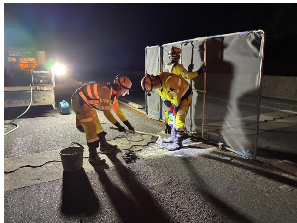
<道路構造物補修>
