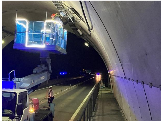
《照明点検状況》
