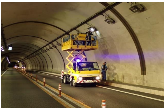
<トンネル照明点検作業>
