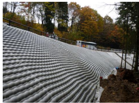
<布製型枠工>
