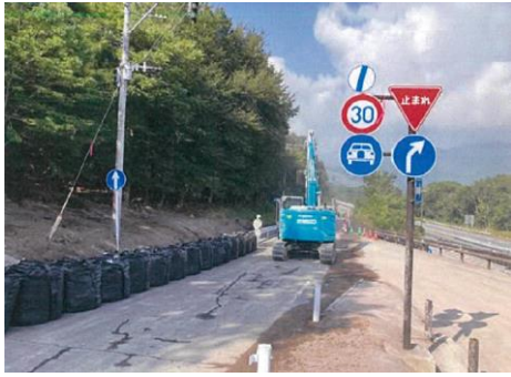
<大型土のう撤去>
