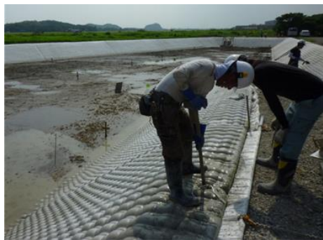
<布製型枠工>
