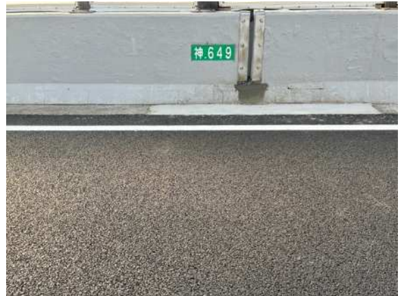
ノージョイント化(工事後)
