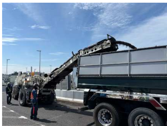
アスファルト舗装の撤去状況
