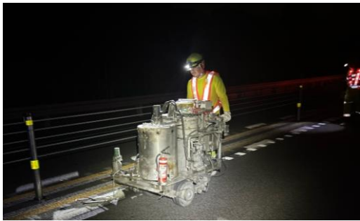
<事故復旧作業>
