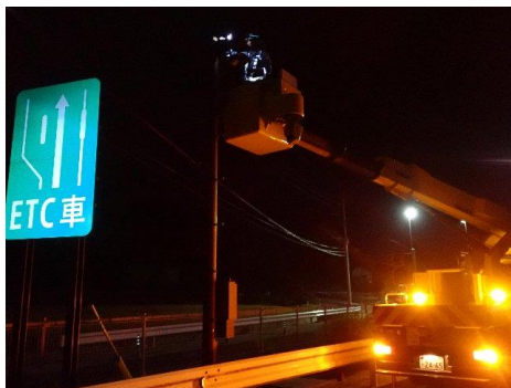
<道路構造物点検>
