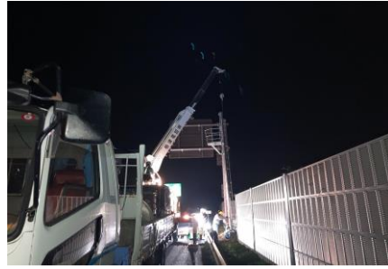
<通信設備工事>
