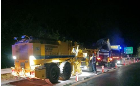
<路面補修工事>
