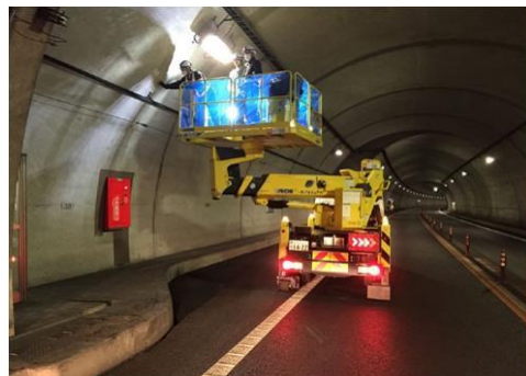
<トンネル照明点検>
