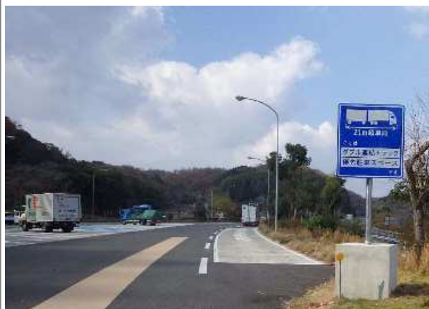
写真-1 E2A 中国道 江の川PA(下り線)
