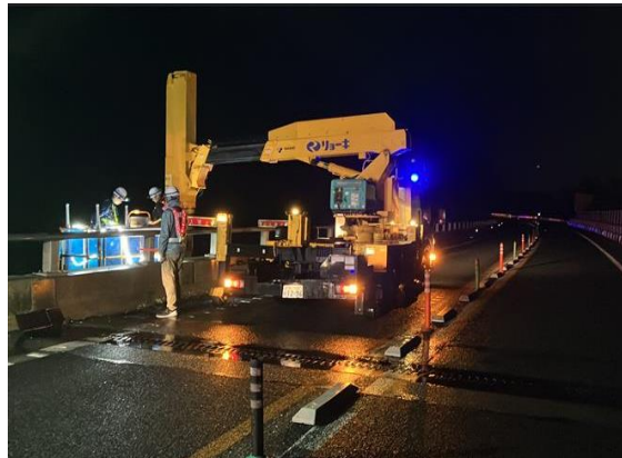
《橋梁点検状況》
