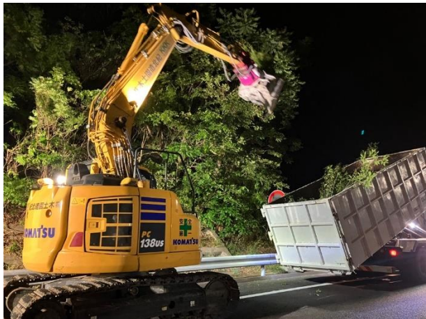
《伐採作業状況》
