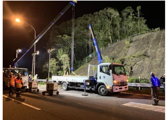
<樹木伐採作業>
