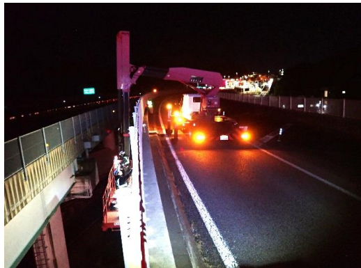
<構造物点検(橋梁)>
