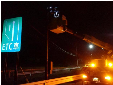
<道路構造物点検>
