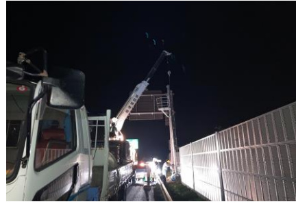
<通信設備工事>
