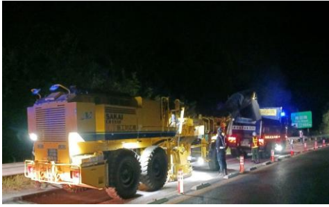
<路面補修工事>
