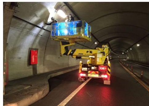
<トンネル照明点検>
