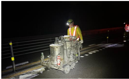
<事故復旧作業>
