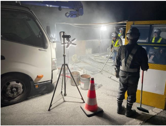
<伸縮装置取替>
