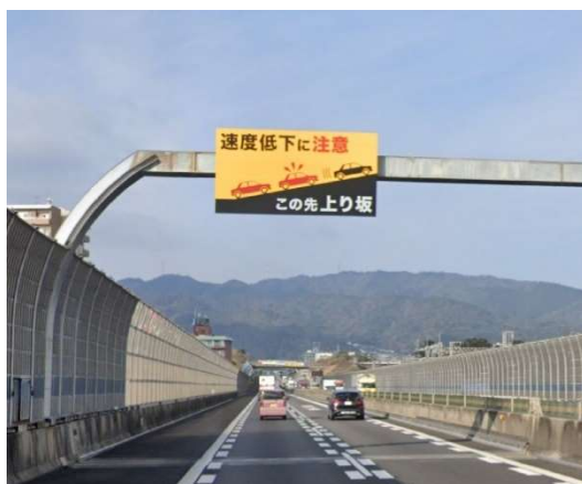
<注意喚起標識の設置状況>
