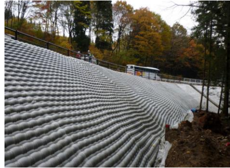
＜布製型枠工＞
