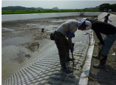
＜布製型枠工＞
