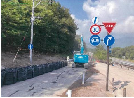
＜大型土のう撤去＞
