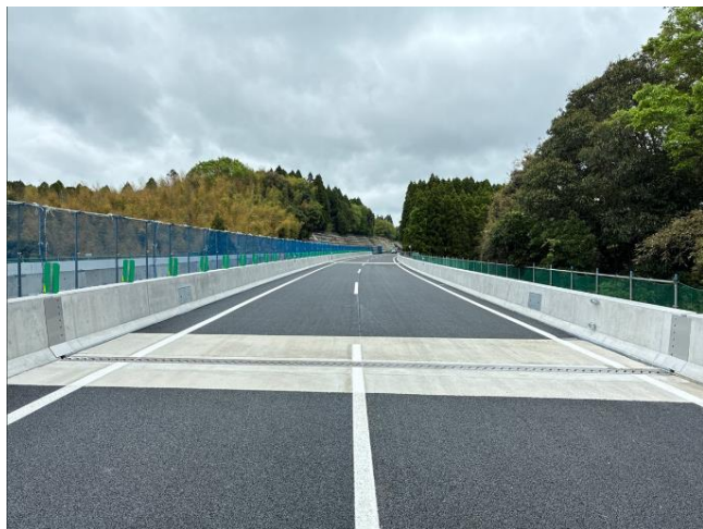
②全景: 施工後
