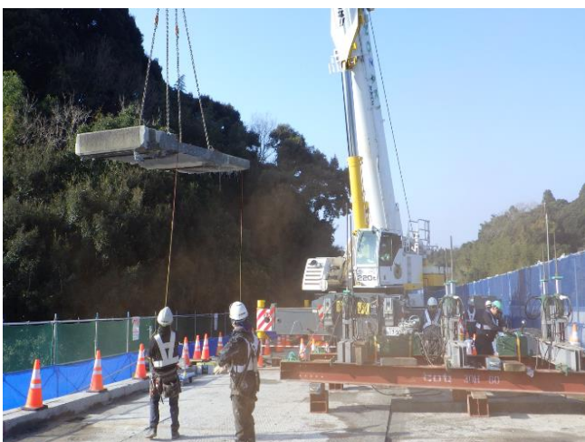
①損傷した床版の撤去作業状況
