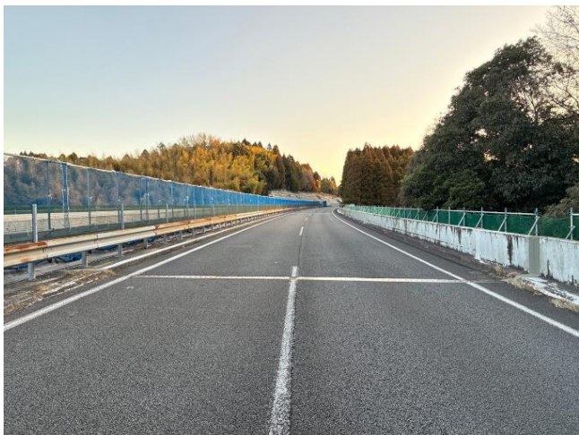
①全景: 施工前
