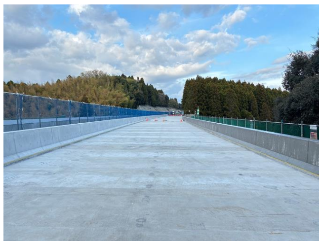
④床版取替 施工後(床版防水工施工前)
