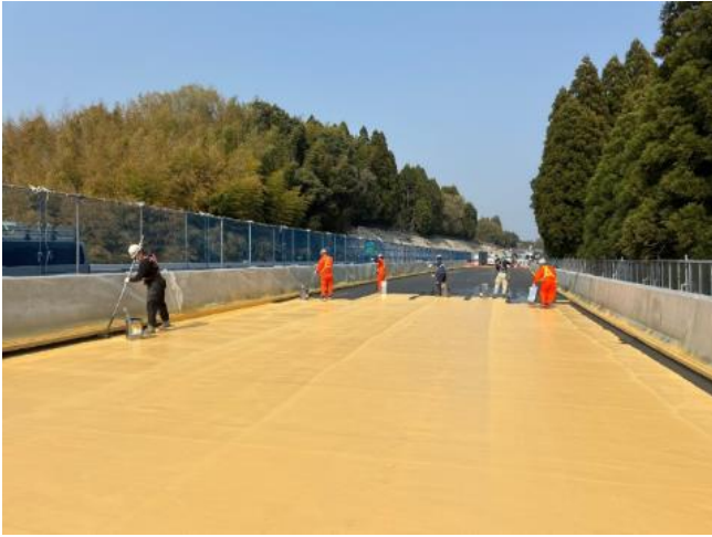
③床版防水工の作業状況
