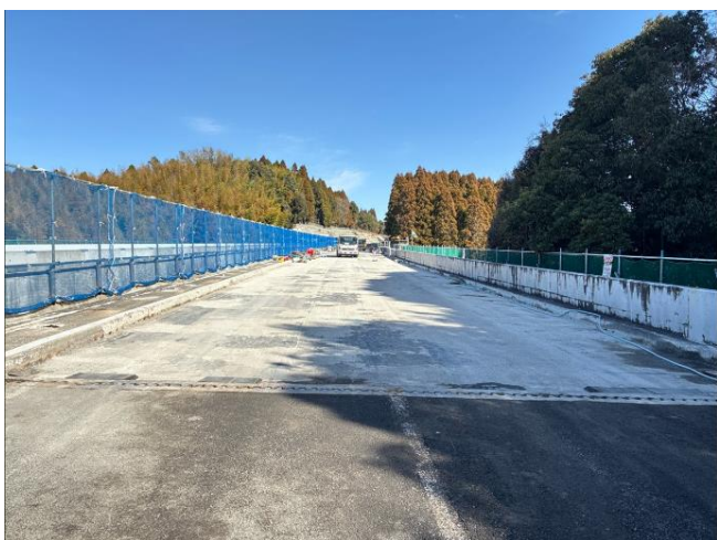
③床版取替 施工前
