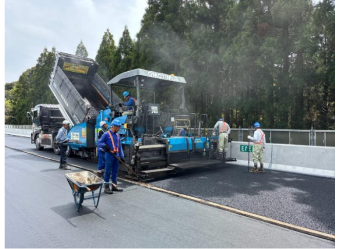
④アスファルト舗装工の作業状況
