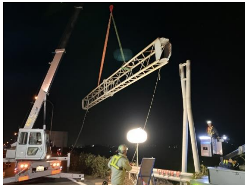
<門型支柱撤去のイメージ>
