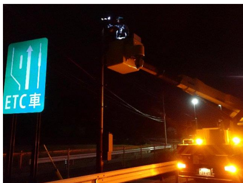
<道路構造物点検>
