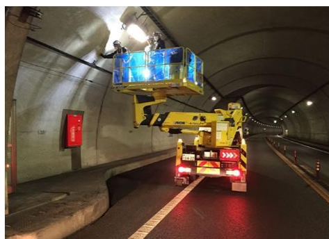
<トンネル照明点検>
