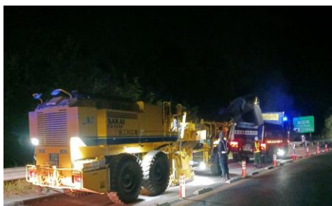
<路面補修工事>
