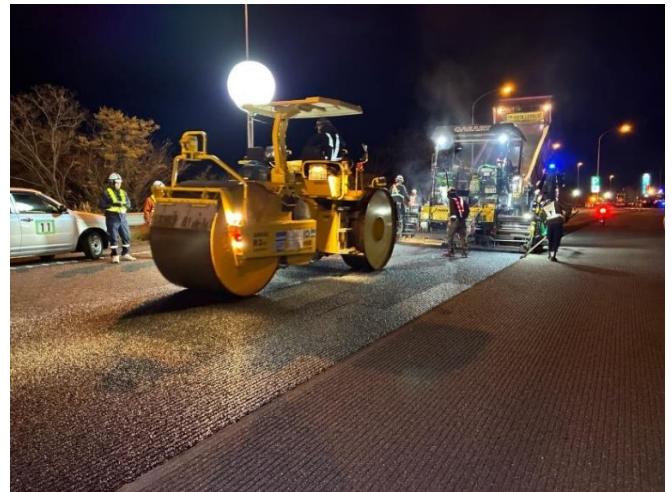
《舗装補修状況》
