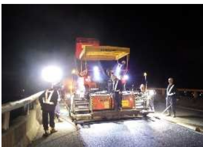
《舗装補修工事》
