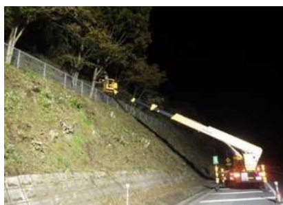
《維持修繕作業(樹木伐採等)》
