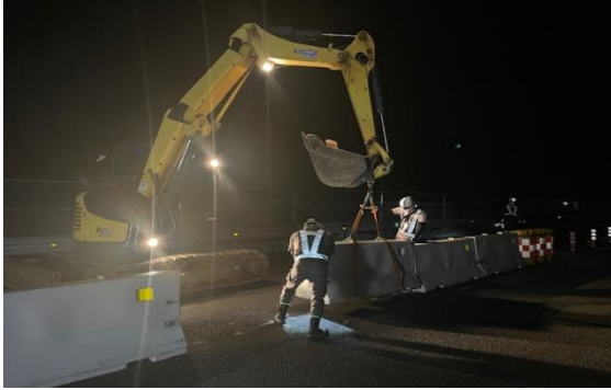
<仮設防護柵設置工事>
