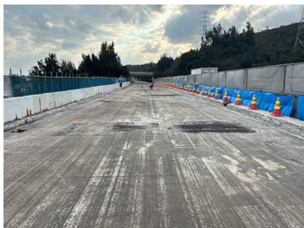
床版取替 施工前
