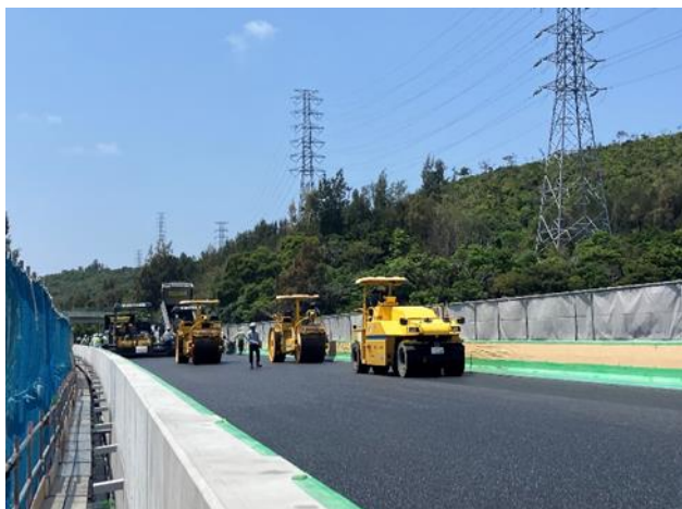
舗装工事の作業状況
