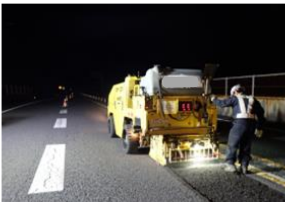
<舗装補修工事>
