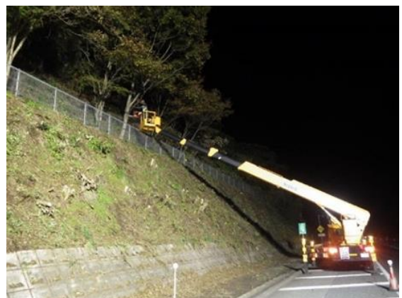
《維持修繕作業(樹木伐採等)》
