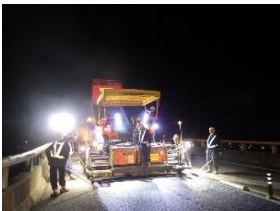
《舗装補修工事》
