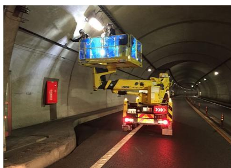
<トンネル照明点検>
