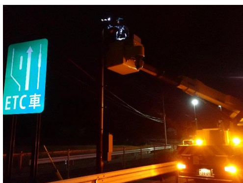
<道路構造物点検>
