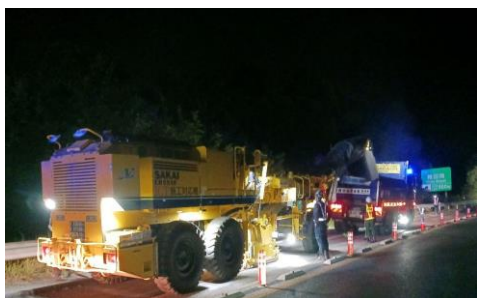
<路面補修工事>
