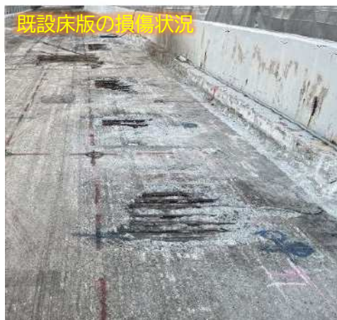
鉄筋が腐食し、床版上面のコンクリートが脆弱化している状況
