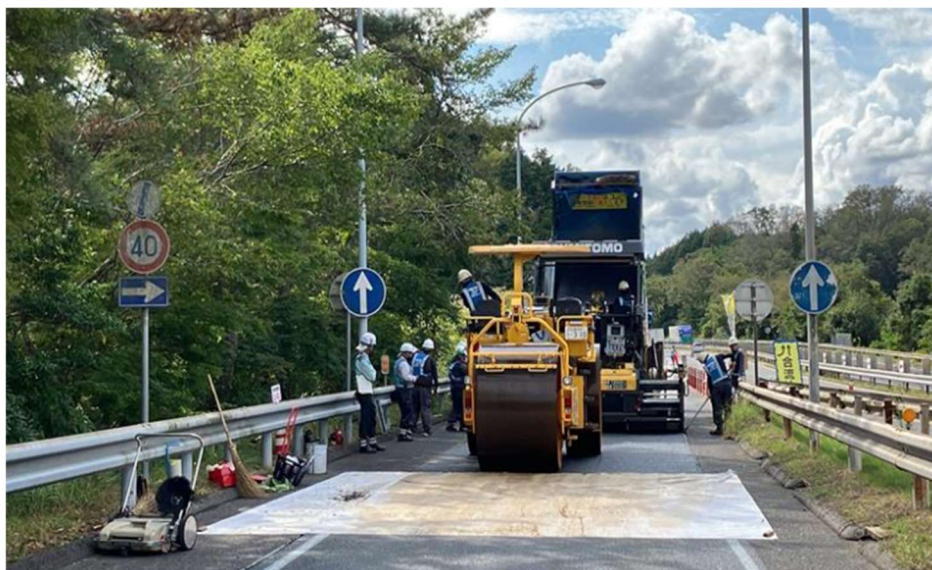
《舗装補修工事》
