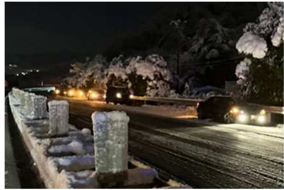
E2 広島岩国道路
