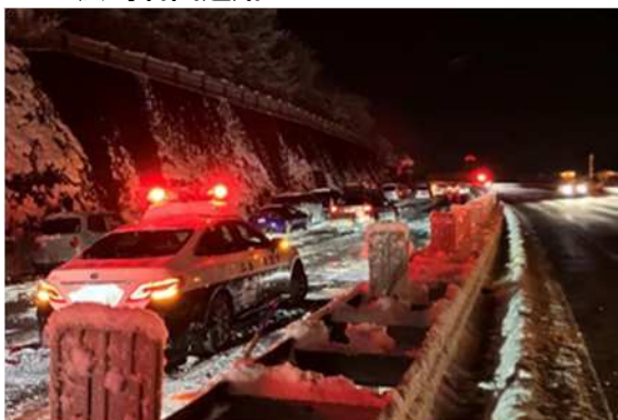
E2 広島岩国道路
