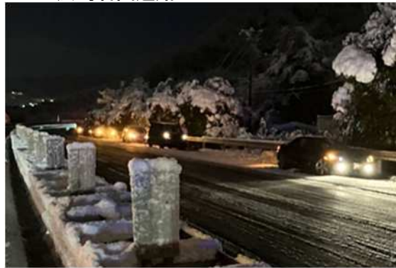
E2 広島岩国道路
