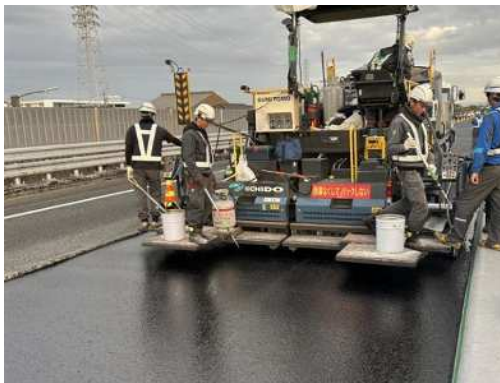
床版防水の施工
