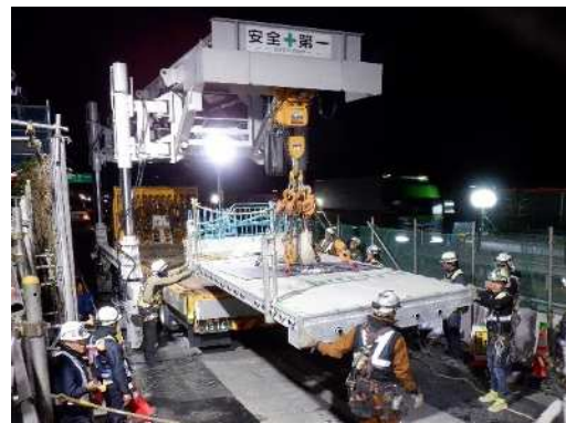
新しい床版の設置
