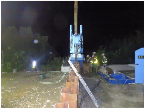
土留め鋼矢板引抜き
