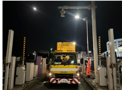
照明設備点検
