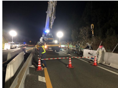
仮設防護柵設置
