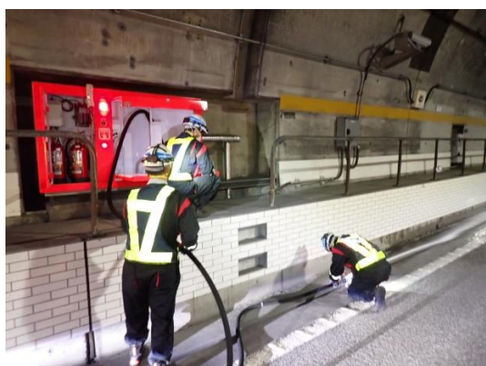
< トンネル非常用設備点検 >
