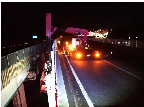
< 構造物点検（橋梁） >
