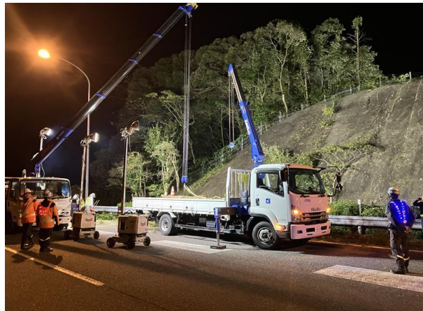
< 樹木伐採作業 >
