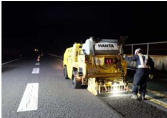
＜舗装補修工事＞
