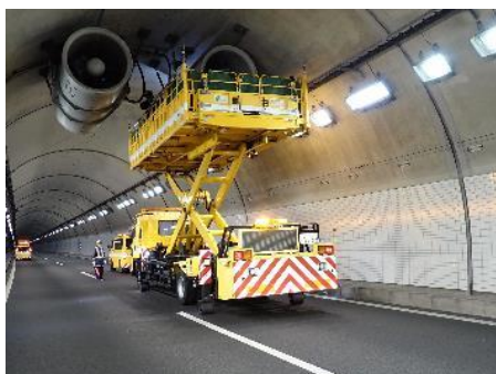
《トンネル内設備点検状況》
