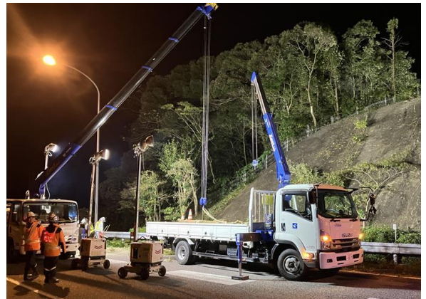
<樹木伐採作業>
