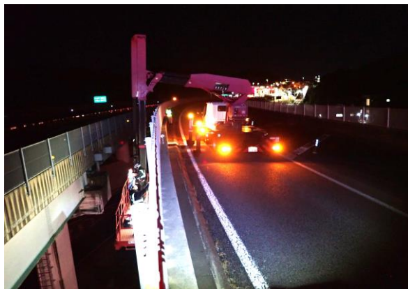
<構造物点検(橋梁)>
