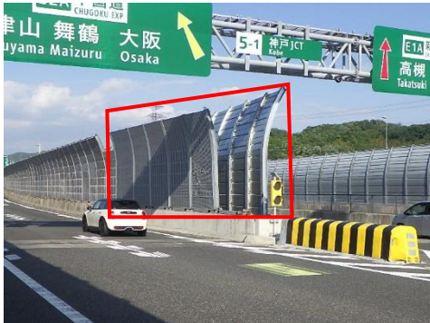
施工箇所(全景)
