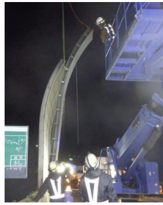
遮音壁取替作業《施工イメージ》
