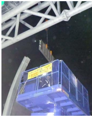
遮音壁取替作業《施工イメージ》
