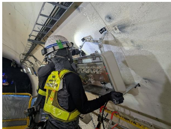
《トンネル照明取替作業状況》
