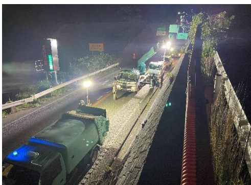
〈樹木伐採作業〉
