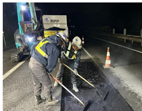
〈路面補修工事〉
