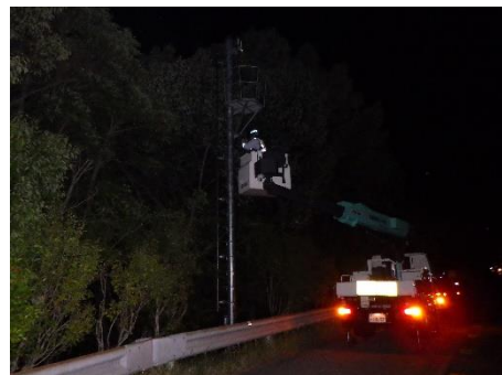
〈道路設備構造点検〉
