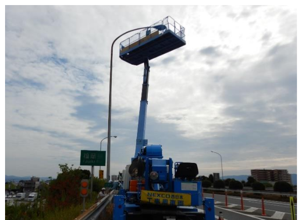
<照明構造・設備点検>
