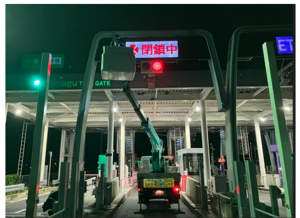
＜ETC 設備工事＞
