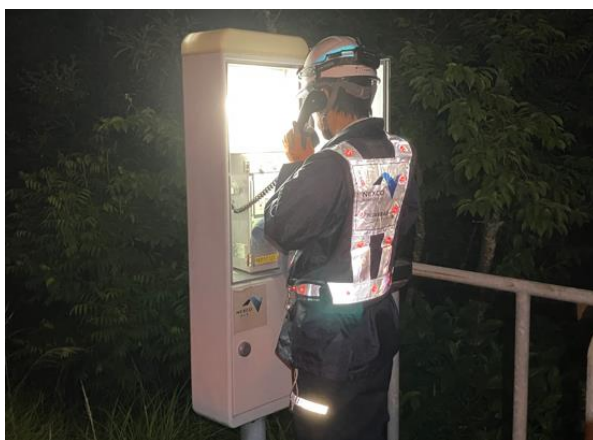
＜非常電話設備点検＞
