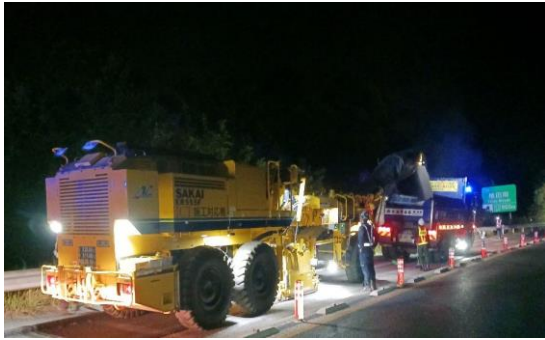
＜路面補修工事＞
