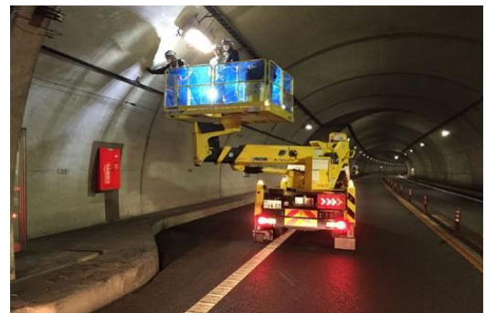
＜トンネル照明点検＞
