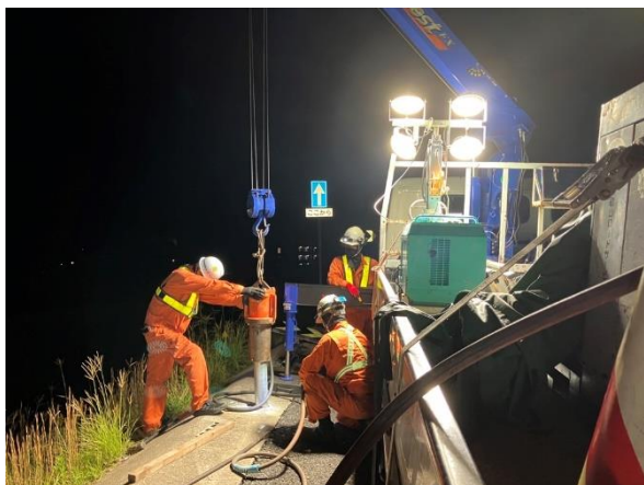
《事故復旧作業状況》
