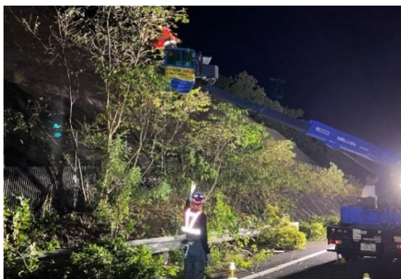
《植栽作業状況》
