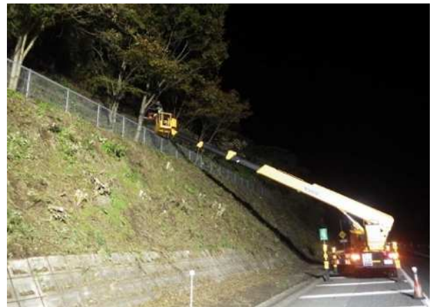
《維持修繕作業(樹木伐採等)》
