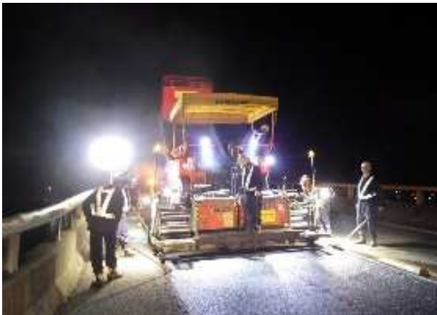
《舗装補修工事》
