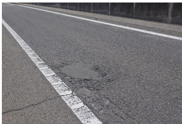
《施工前 or 施工中》
