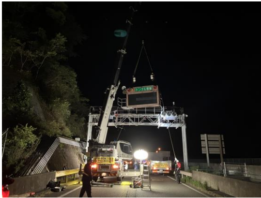
＜情報板更新工事＞
